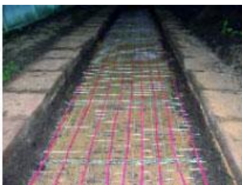
Рисунок 3.5 Укладка нагревательной секции на металлической сетке
