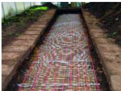
Рисунок 3.7 Укладка металлической сетки над секциями кабеля
