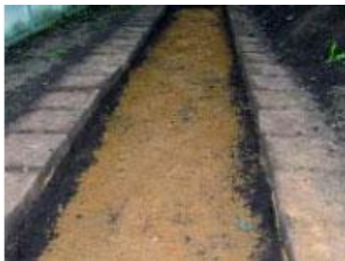
Рисунок 3.4 Укладка песчаного основания
