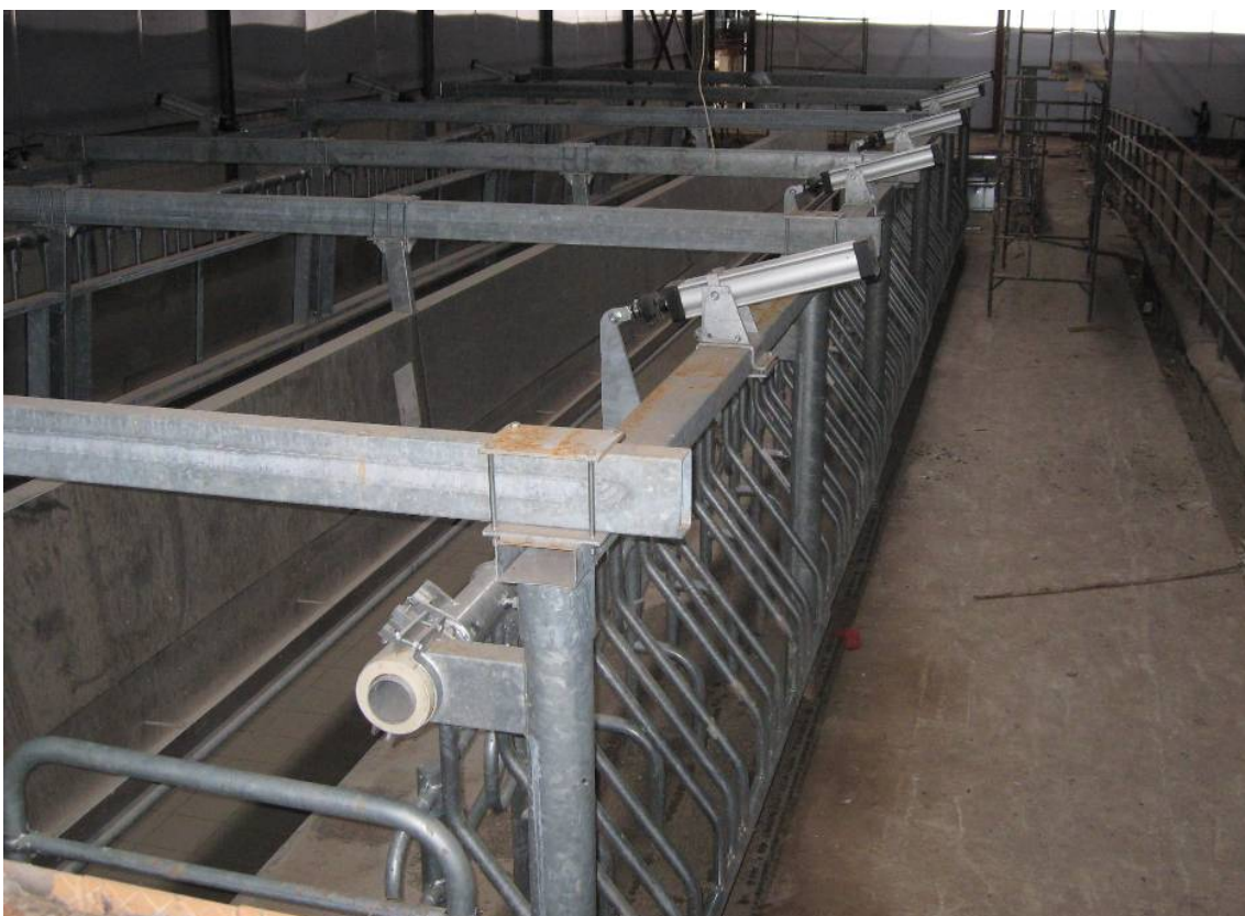
Рисунок 17. Монтаж доильного зала типа «Параллель» «InterPuls» (ГУСП совхоз Рощинский)
