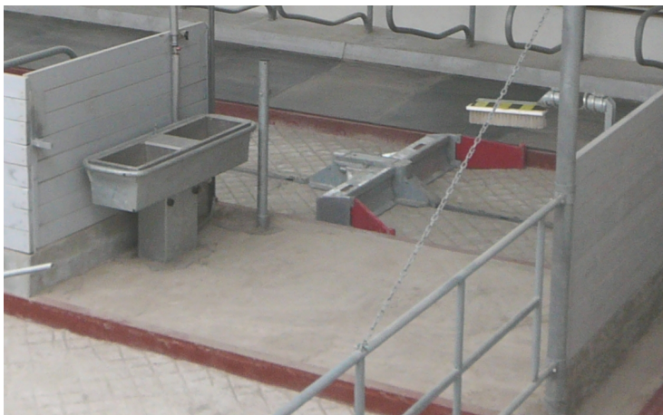
Рисунок 8. Опрокидывающаяся поилка с подогревом «Farmtec» (коровник ГУСП совхоз Алексеевский)
