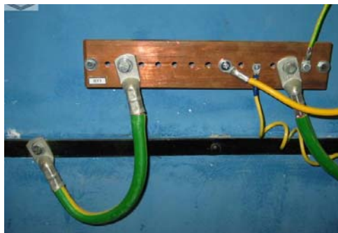
Рисунок 2.5 Главная заземляющая шина
