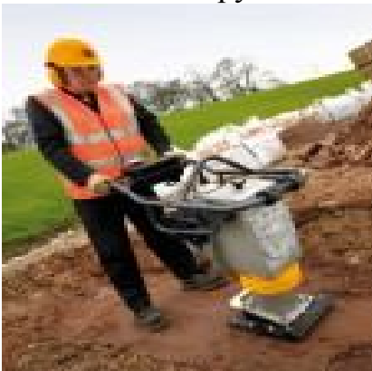
Рис. 7.2. Вибротрамбовка: общий вид и трамбовка участка.
