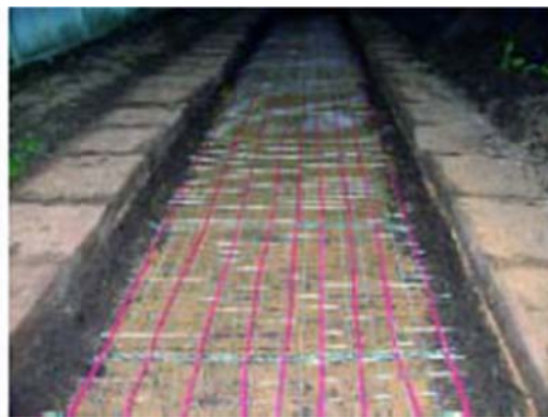
Рисунок 3.5 Укладка нагревательной секции на металлической сетке
