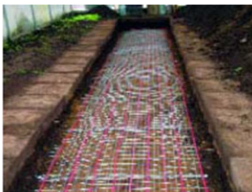
Рисунок 3.7 Укладка металлической сетки над секциями кабеля
