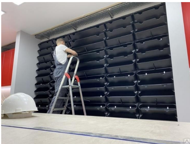
Рисунок 4 – Процесс монтажа фитостены
